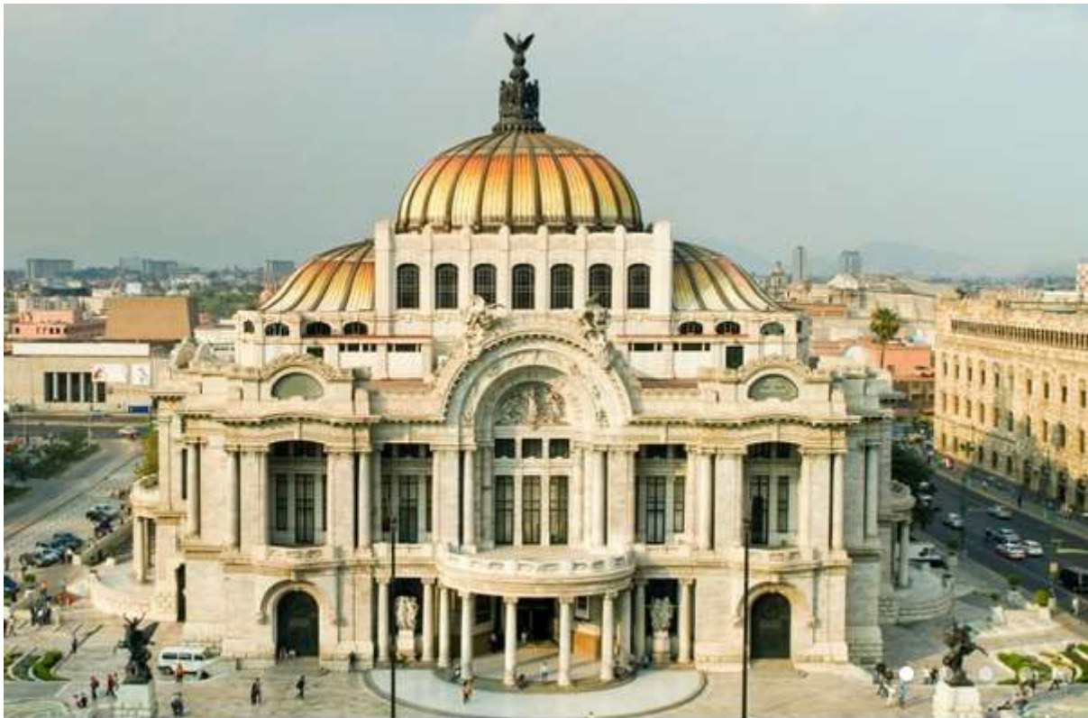
Palacio de Bellas Artes de México. D.F; construido durante la época porfiriana. (durante el porfiriato)
